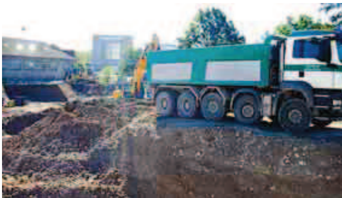
Alte Leitung und Fundamentreste vom 9. Oktober 2014
