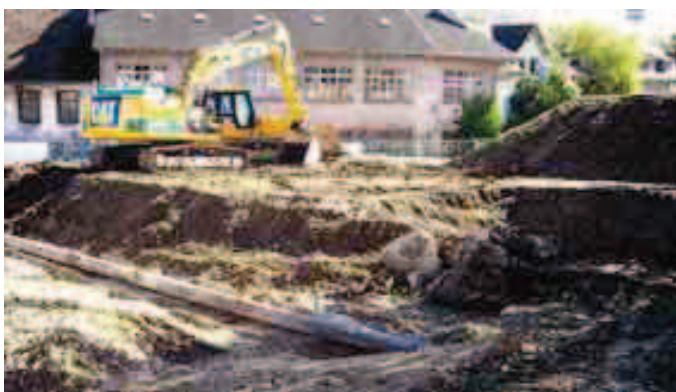
Aushub am 9. Oktober 2014
