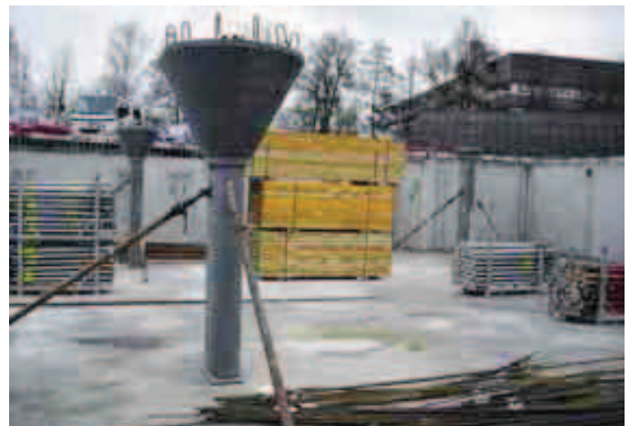
Stützen im unteren Teil der Tiefgarage
