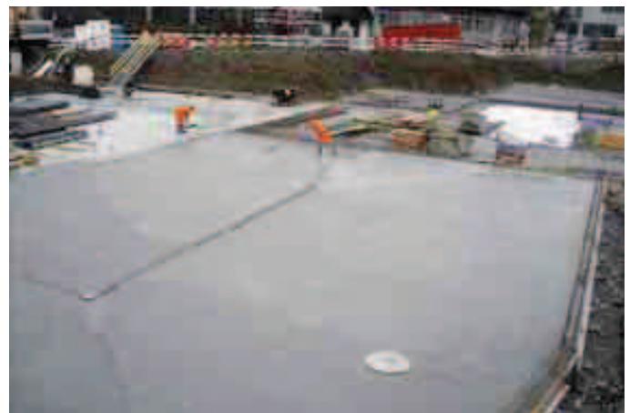
Im oberen Teil der Tiefgarage wird der Boden betoniert
