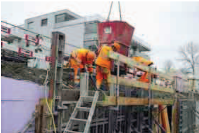
Betonierarbeiten an Wänden in vollem Gange
