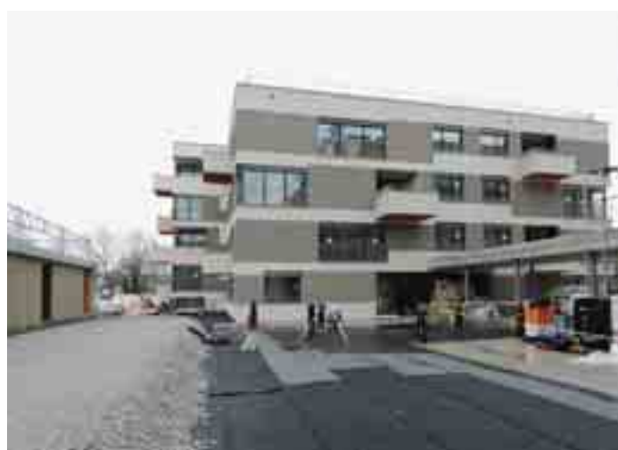
Haus A: Fertige Fassade ohne Gerüst
